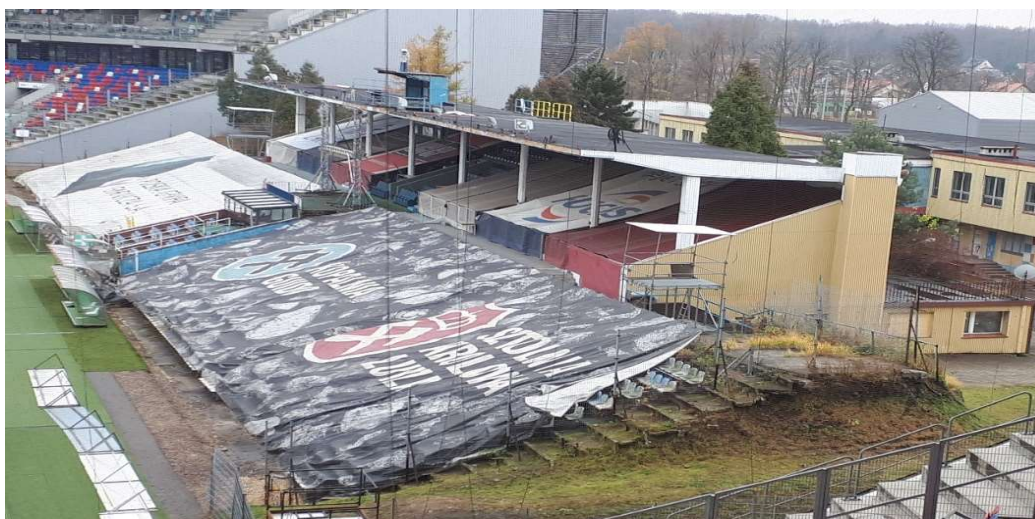
Fot. 3 - Bud. szatni z trybuną – widok od strony północnej
