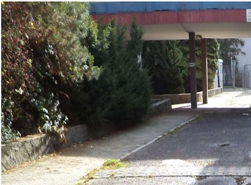
Fot. 11 - Murki z kamienia
