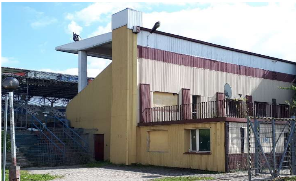
Fot. 5 - Widok budynku szatni od strony północno - zachodniej
