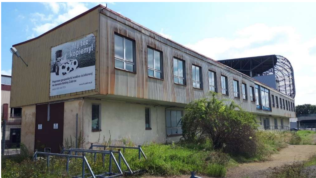
Fot. 2 - Budynek administracyjno – biurowy widok od strony północno- zachodniej
