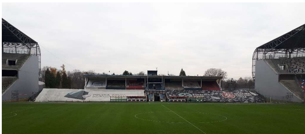
Fot. 4 - Widok na zadaszoną trybunę od strony płyty boiska
