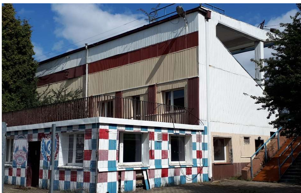
Fot. 6 - Widok budynku szatni od strony południowo - zachodniej
